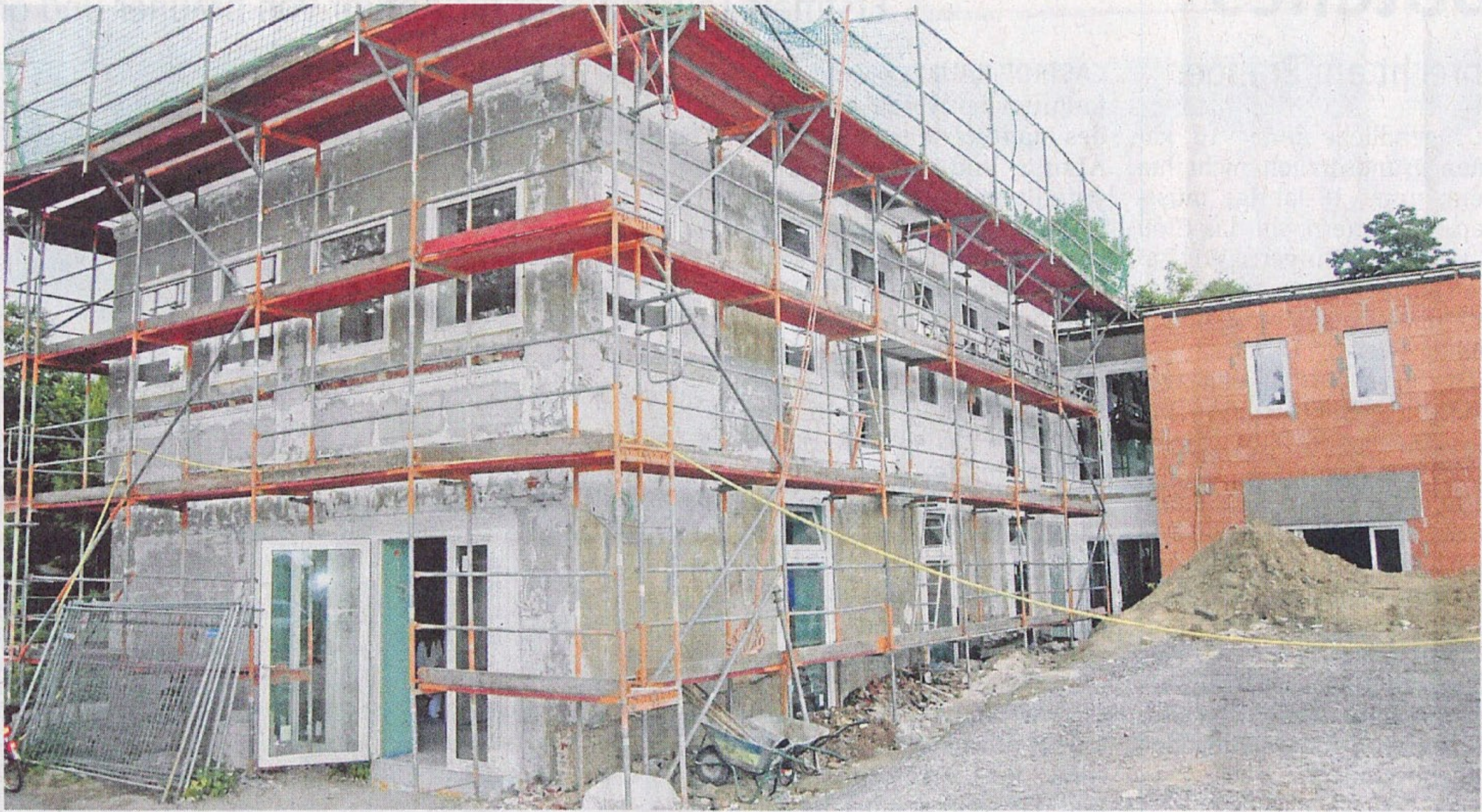
Aus der Wartburg wird nach der Fertigstellung des Baus das Riad.
