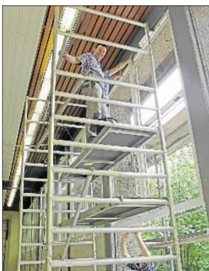
Neue Fenster setzt die Firma Klöcker in der Turnhalle ein. RN-Foto
