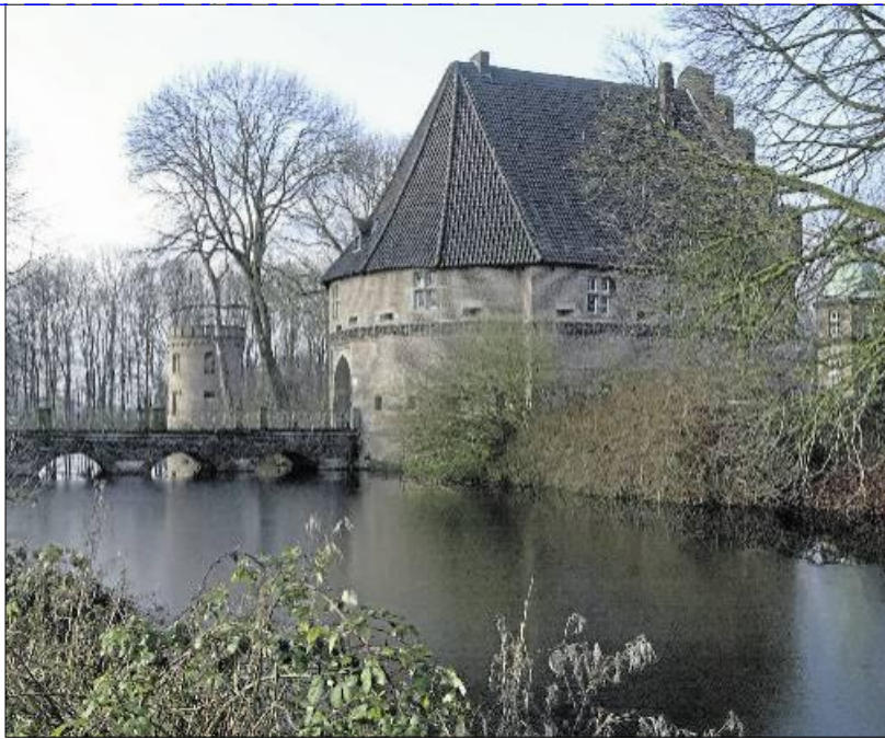
Die Bezirksregierung Münster hat Gelder für das denkmalgeschützte Torhaus von Schloss Bladenhorst bewilligt: 80.000 Euro werden für die Sanierung bereit gestellt. Davon will Eigentümer Bodo Mohrke den schiefen Giebel richten lassen. RN-Foto Archib
